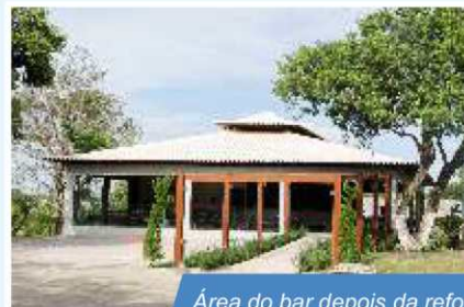
Área do bar depois da reforma
